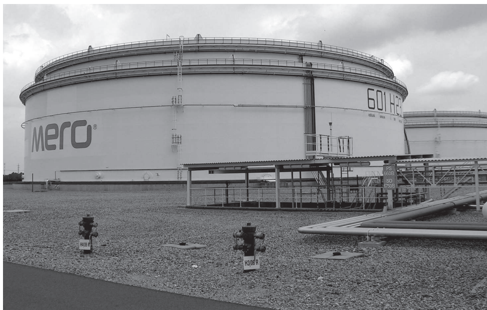
Obrázek 99: Válcový stojatý zásobník určený pro skladování ropy (foto: Petr Skřehot).
