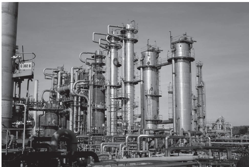
Obrázek 97: Soustava kolon určená pro parciální oxidaci při zplyňování mazutu (foto: Unipetrol RPA, s. r. o.).
